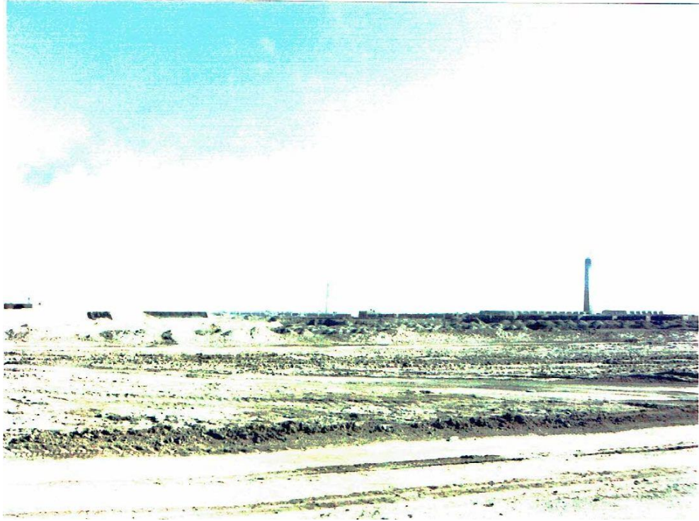
صورة (5): معامل الطابوق قرب موقع الطلي ويبدو واضحاً الدخان الملوث للبيئة - أخذت الصورة بتاريخ 2010-11-13
